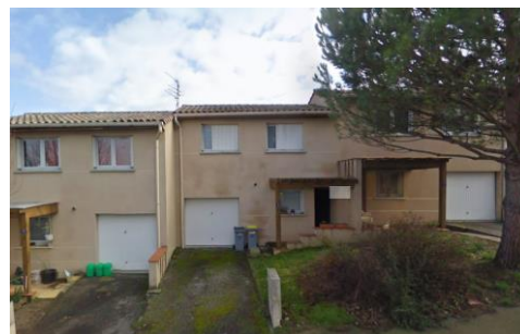
Habitation mitoyenne des Cornouillers (Source : Google Street View)
