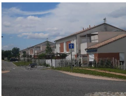
Stationnement groupé des voitures, à l'arrière de la construction
