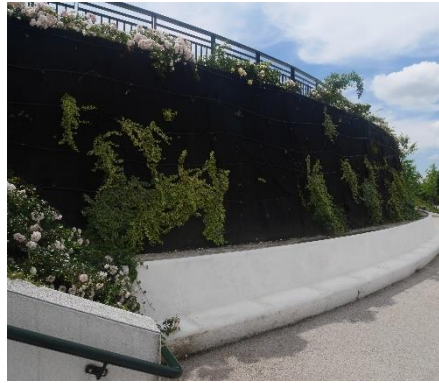
Mur végétalisé en haut du mail
